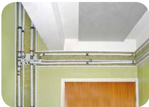
Underdel och vattenledning installerade
